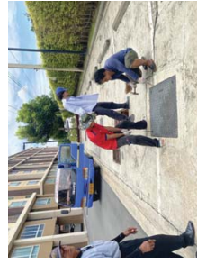
การสูบล้างท่อจากระบบบำบัดน้ำเสีย
