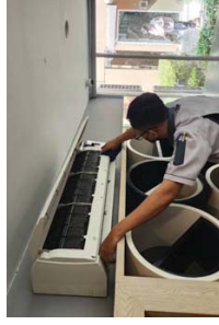
การล้างทำความสะอาดเครื่องปรับอากาศ
